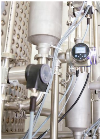
Abb. 2: FLOWave ermöglicht das kontinuierliche Monitoring der Reinigungsprozedur und ist damit ein echtes Werkzeug für die Qualitätssicherung.
