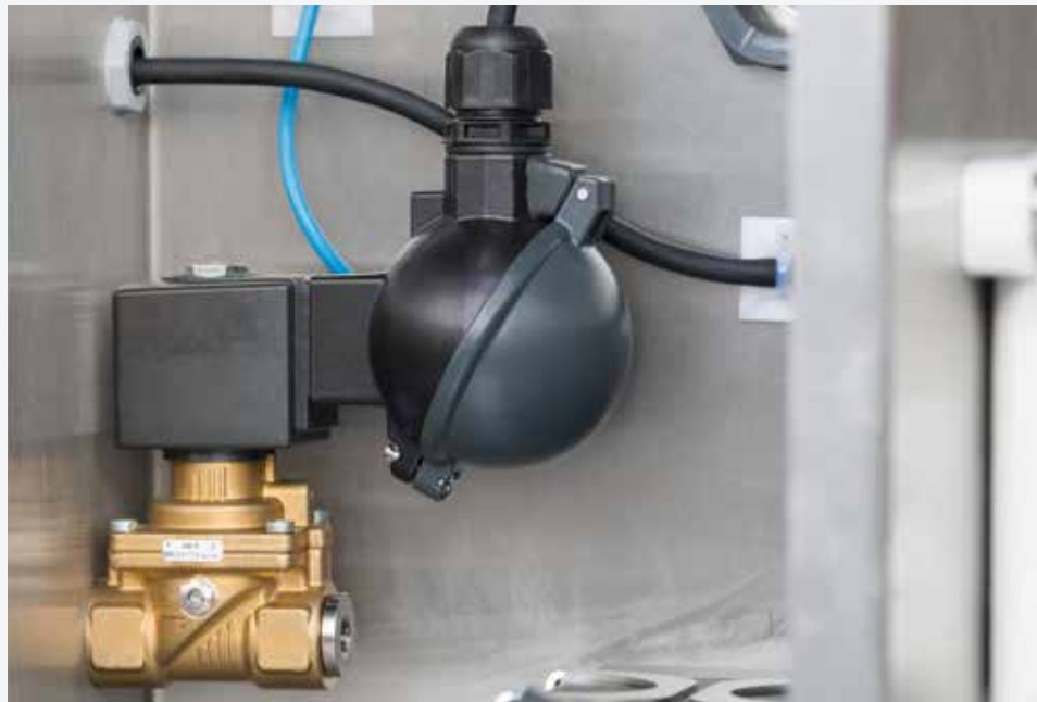
Ex- Magnetventile für eine optimale Überdruckkapselung in Schaltschränken
