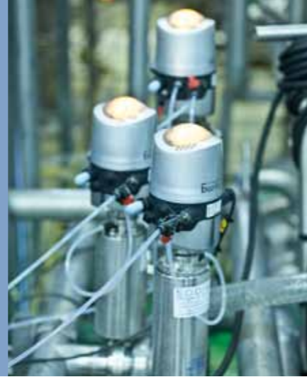
Universeller Steuerkopf Typ 8681 auf verschiedenen Prozessventilen
