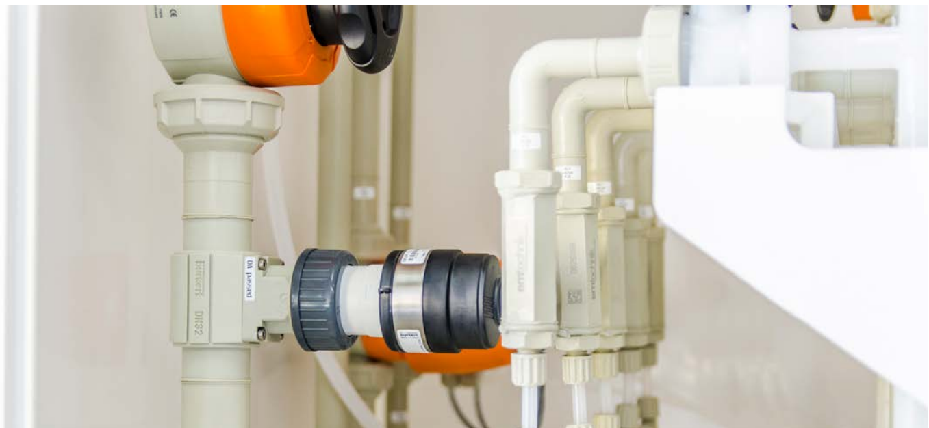
Konduktives Leitfähigkeitsmessgerät zur Qualitätsüberwachung von Reinstwasser. (Quelle: RENA Technologies GmbH)
