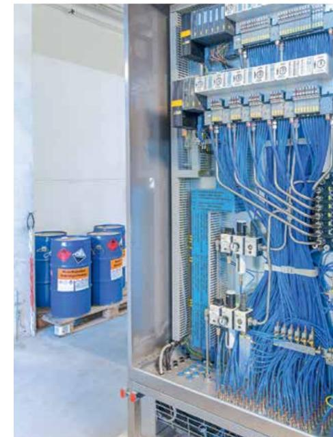
Die neue Lösung reduziert den Platzbedarf und den Installationsaufwand immens, da nur Stromversorgung und Profibuskabel angeschlossen werden müssen.
