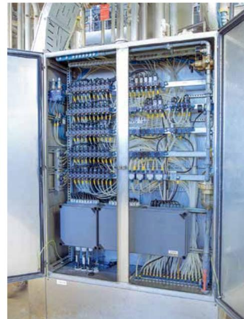
In den alten Bürkert-Schränken war aufgrund der Baugröße der alten Ventile nur eine begrenzte Zahl an pneumatischen Signalen möglich. Auch der „EX-e“-Verdrahtungsaufwand war deutlich höher.
