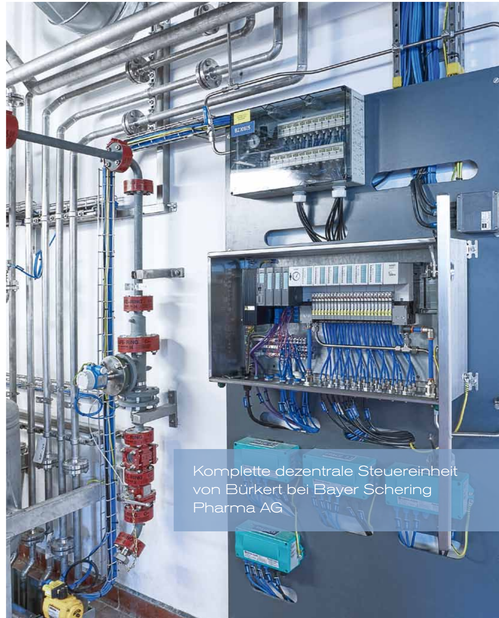
ATEX-zertifizierter Schaltschrank bei der Bayer Schering Pharma AG
