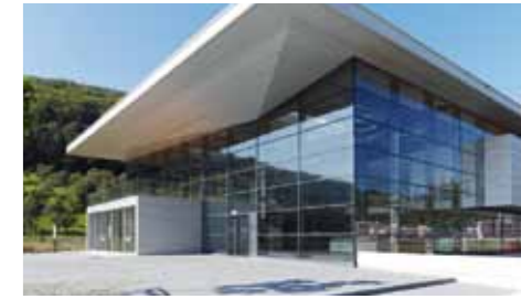
Systemhaus Ingelfingen DEUTSCHLAND
